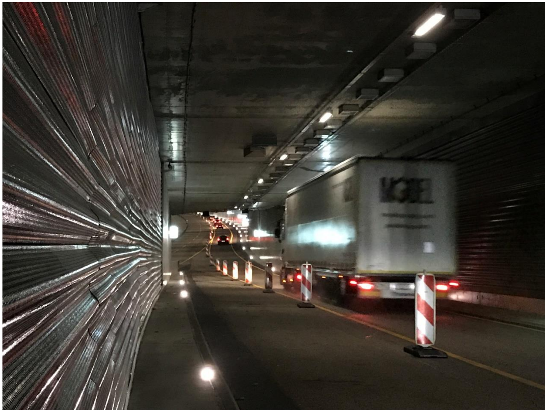
Bildunterschrift: Der neue Tunnel in Stellingen ist noch nicht abschließend eingestuft. (Foto: ©bwvi_k.fischer)
